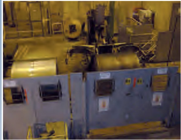
Flejadora en posición de flejado radial de bobinas en caliente, con fleje de acero de 32mm.
